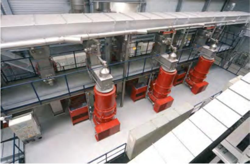
▲ Installation de granulation des ordures ménagères pour la production des granulés ou du fluff
